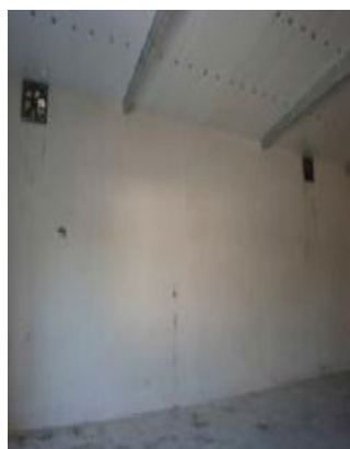
شکل ۱۰۶- نمونه‌ای از وضعیت لبه‌های سقف و موقعیت پنجره‌ها، دیوارها و عایق‌بندی امتداد شیروانی به منظور سایه-اندازی روی دیوار انبار و استفاده از مواد عایق در سقف انبار
