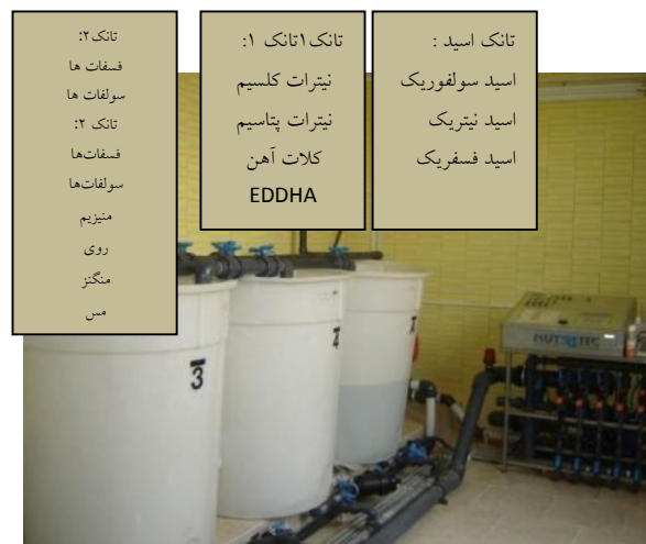
شکل ۳۰- استفاده از تانک های مجزای مواد کودی به منظور جلوگیری از ترسیب کودهای ناسازگار در روش کود آبیاری
