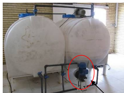
شکل ۲۷- مخزن‌های کود با تزریق کننده ضربه‌ای و دمنده هوا جهت هم‌زدن و انحلال کامل کود
